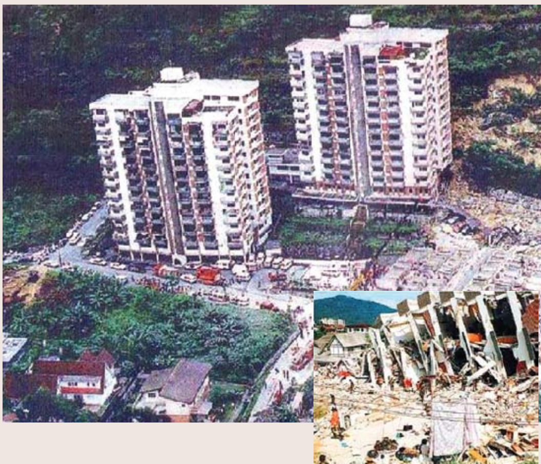
Rajah 2.3: Keruntuhan Highland Towers yang mengorbankan 48 nyawa
